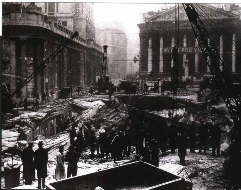
1941年1月11日晚，德国用 SC—1800 型炸弹对伦敦的金融区进行轰炸，此图为援救队在清理地下火车站的售票大厅废墟。炸弹杀死 50 多人并阻断了一架七路立交桥，但是三周之内，英国人就架起了一座临时桥，交通又恢复正常。
