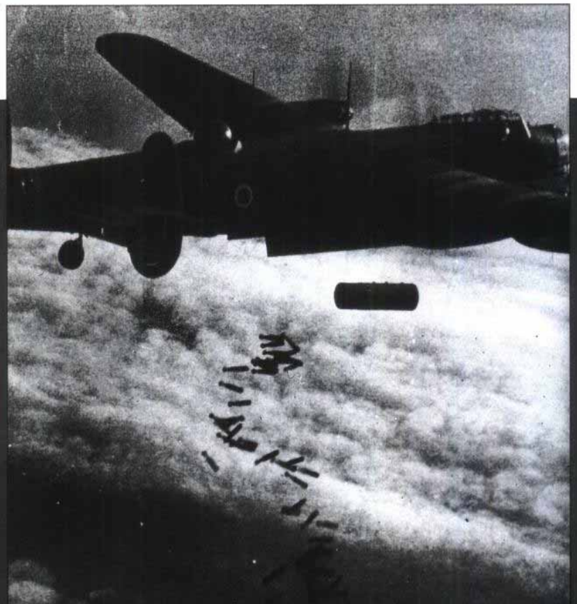
不列颠的阿英罗·兰开斯特号投下了一颗高能量炸弹和一些燃烧弹。炸弹能摧毁屋顶和玻璃窗，燃烧弹能点燃整个建筑。如果在不用炸弹的情况下，燃烧弹就容易从尖顶房屋上滑落到街道上，从而熄灭失去作用。
